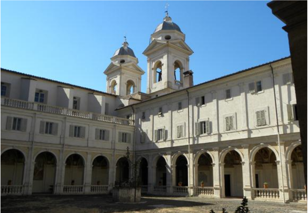
Il chiostro, prima e dopo il recente restauro.
